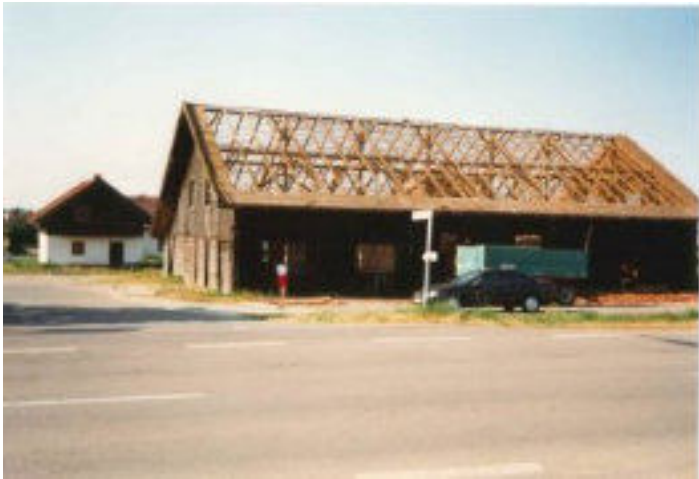
Bild: Sägewerk Bauer beim Abbruch
