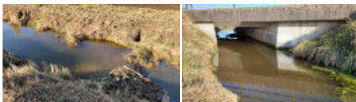
Bild: Biberbauwerke stauen den Dorasgraben in Bamling an
