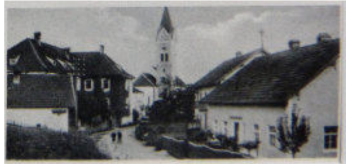
Bild: Ortseinfahrt rechts die Schusterwerkstatt, links vorne das Hirtenhaus.
