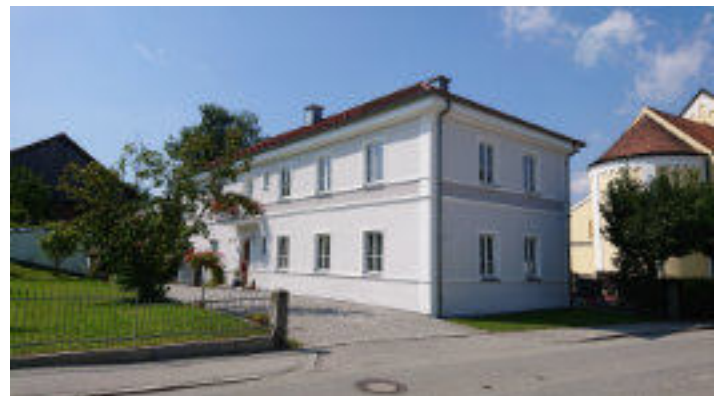
Bild: Mehr als ein Jahrhundert liegen zwischen der Nutzung als Schule und dem stilvoll renovierten Wohnhaus.
