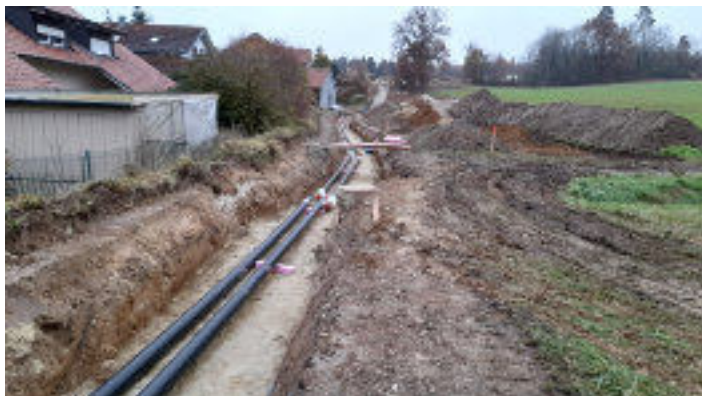
Bild: Die Hauptleitungen sind in Teilabschnitten fertig verlegt
